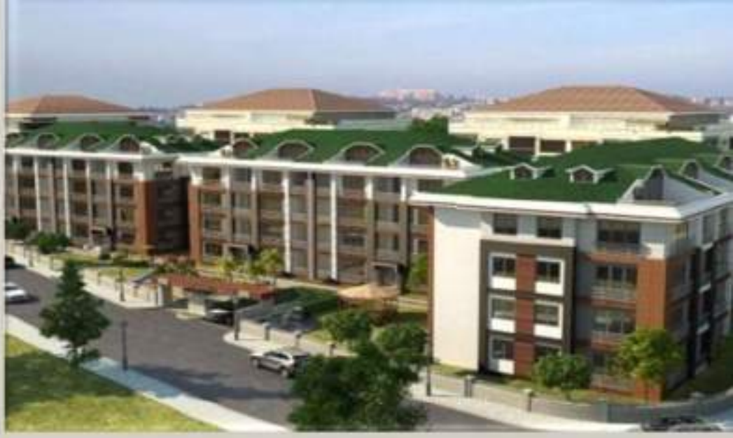
Söğüt İnşaat Söğüt Park Evleri (Büyüçekmece) 80 Apartment
