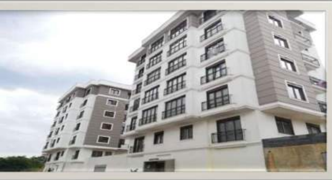
Ak Atılım İnşaat Erguvan Evleri (Alemdağ) 28 Apartment
