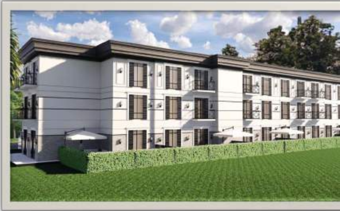
Koçsu İnşaat (Sapanca) 30 Apartment
