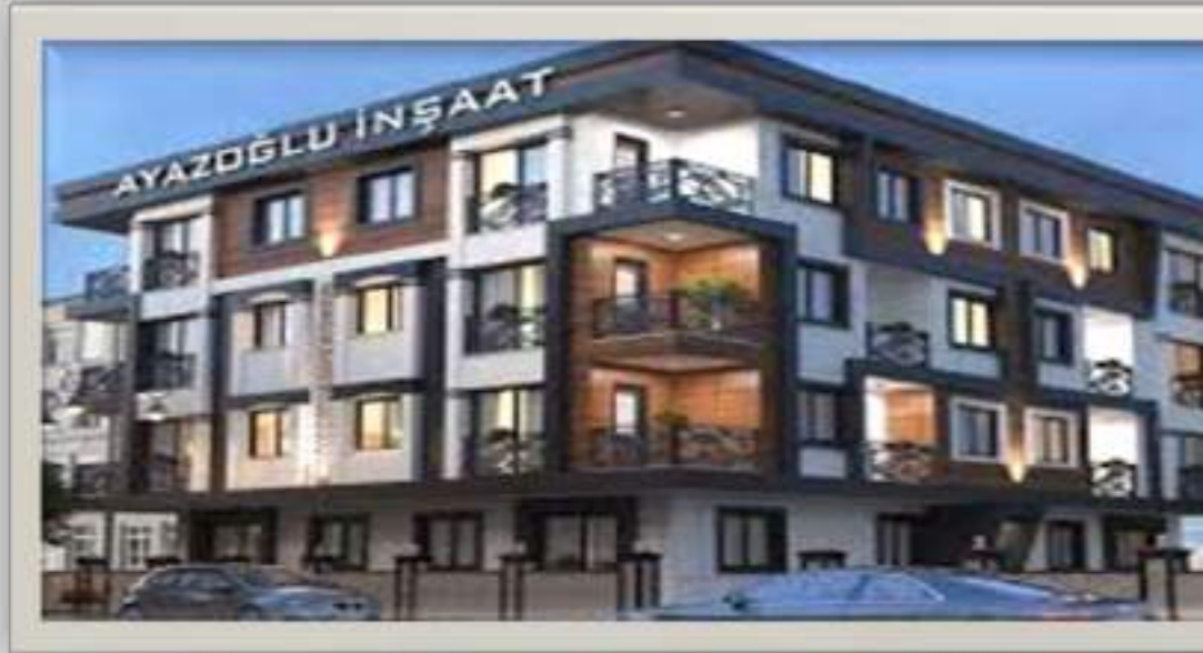
M.Ayazoğlu İnşaat (Ünalın Üsküdar) 20 Apartment
