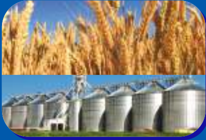
Grain Storage Silos Silos de stockage de céréales
